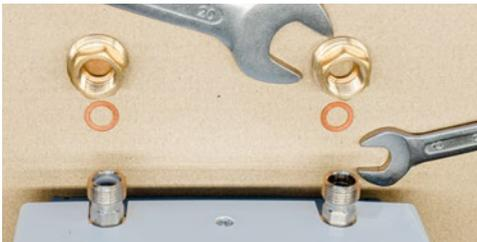
5. Die zwei Messing-Reduzierstücke mit zwischenlegen von jeweils einem Kupfer-Flachdichtring an den zwei Wasserstutzen des E-Kompaktdurchlauferhitzers fachgerecht montieren.
